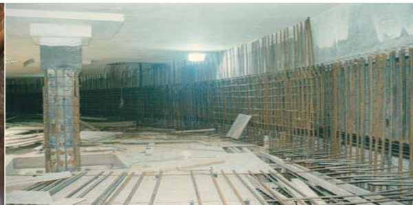
شکل ۳-۹۵ اجرای یک دیوار حائل بر روی دیوار حائل مدفون شمعی به صورت مرحله‌ای و از بالا-پایین
