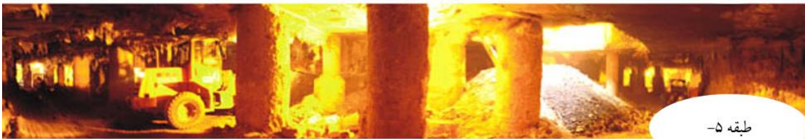
شکل ۸-۱ مرکز آلفا-آربت ۱ روسیه، مسکو، ۵ طبقه زیرزمین. فرایندها و مراحل مختلف اجرایی در طبقات مختلف بطور همزمان
