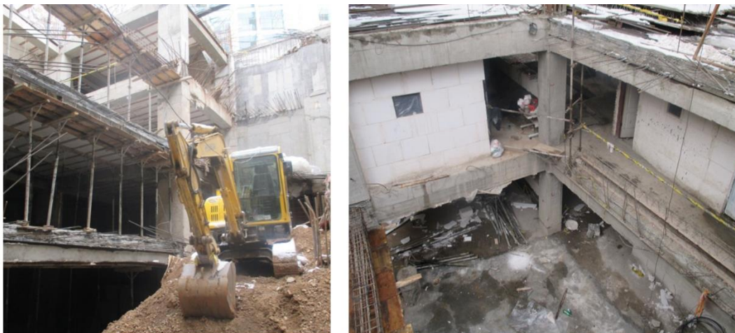
شکل ۱-۱۷ پروژه دیباجی جنوبی - الگوی بومی- اسکلت بتنی با ستونهای درجاریز- عمق گودبرداری ۱۴ متر
