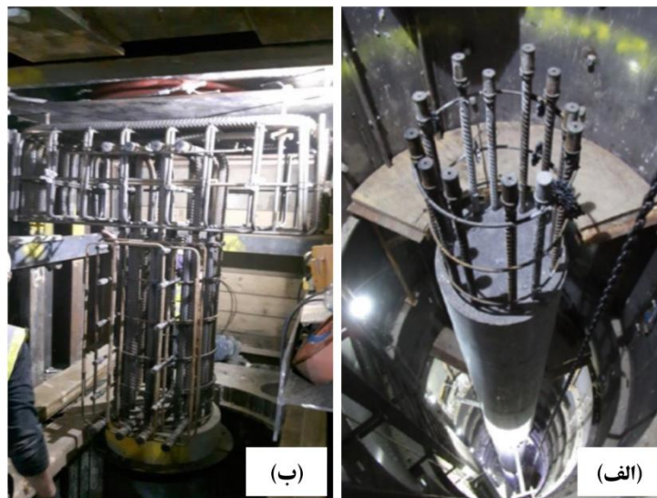
شکل ۳-۳۹ نمونه‌ای از اجرای ستون بتنی داخل چاه و از پایین به بالا؛ (الف) بتن‌ریزی مرحله به مرحله ستون از پایین به سمت بالا و مهار ستون ریخته شده به دیواره چاه - (ب) قرار دادن میلگردهای انتظار با اتصال مکانیکی (کوپلر) جهت اتصال ستون به تیر
