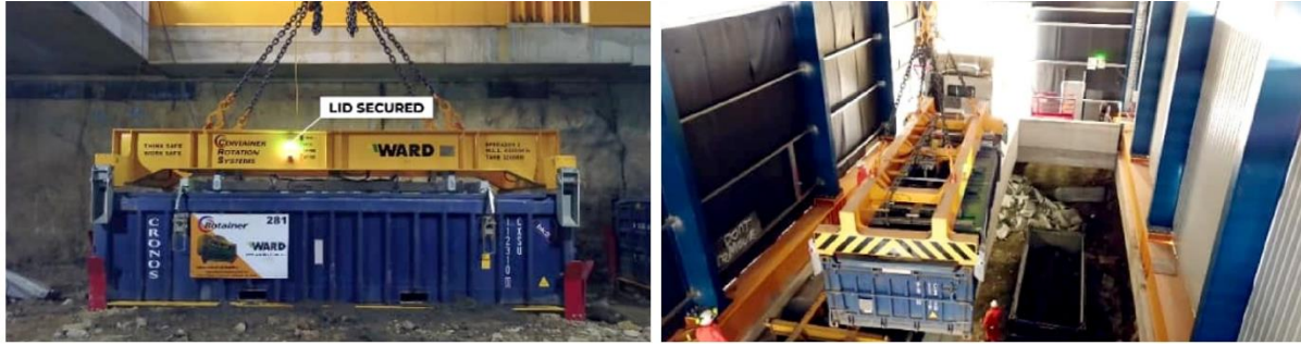
شکل ۳-۸۴ استفاده از جرثقیل دروازه‌ای برای بلند کردن و بیرون کشیدن کانتینر حامل خاک آلوده به مواد نفتی در یک پروژه ساخت به روش بالا-پایین.
