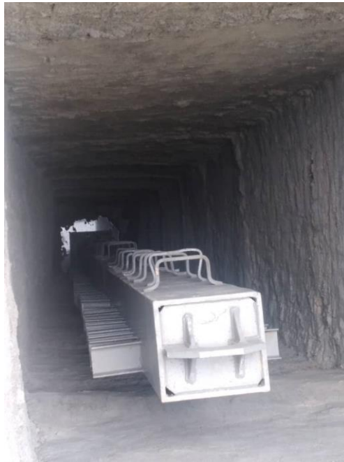
شکل ۳-۲۸ نصب ستون فلزی در سازه فلزی به روش بالا-پایین بر روی پیچ (بولت) های کف ستون و روی شمع در چاه.
