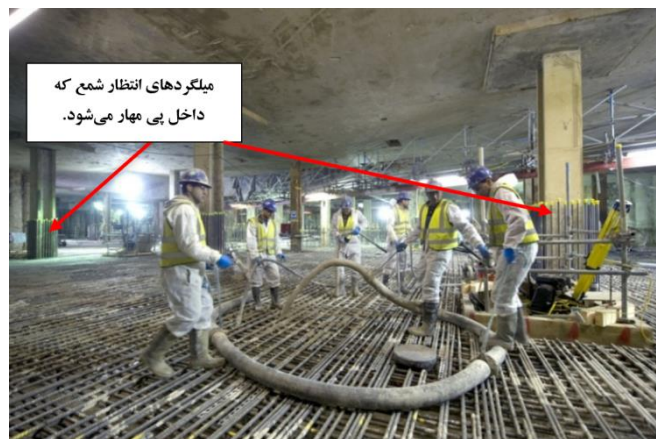
شکل ۳-۱۱۳ آرماتوربندی و بتن‌ریزی پی در ساخت به‌روش بالا-پایین با ستون‌های فولادی
