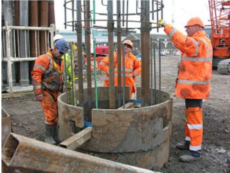
شکل ۳-۴۵ استفاده از غلاف فولادی در سر چاه جهت نصب و وصله شبکه میلگرد شمع.
