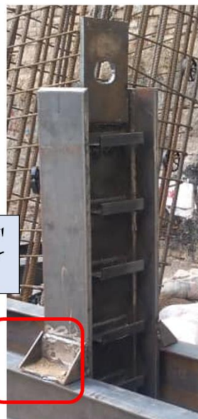
شکل ۳-۲۹ اتصال نبشی نشیمن در تراز ارتفاعی مورد نظر نصب معلق در هنگام ساخت ستون در کارخانه ساخت اسکلت.
