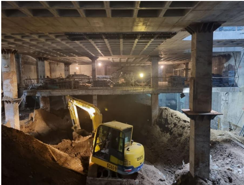
شکل ۳-۶۹ کار کردن یک دستگاه مینی‌بیل در فضای زیرزمین در اجرای سازه به روش بالا-پایین.
