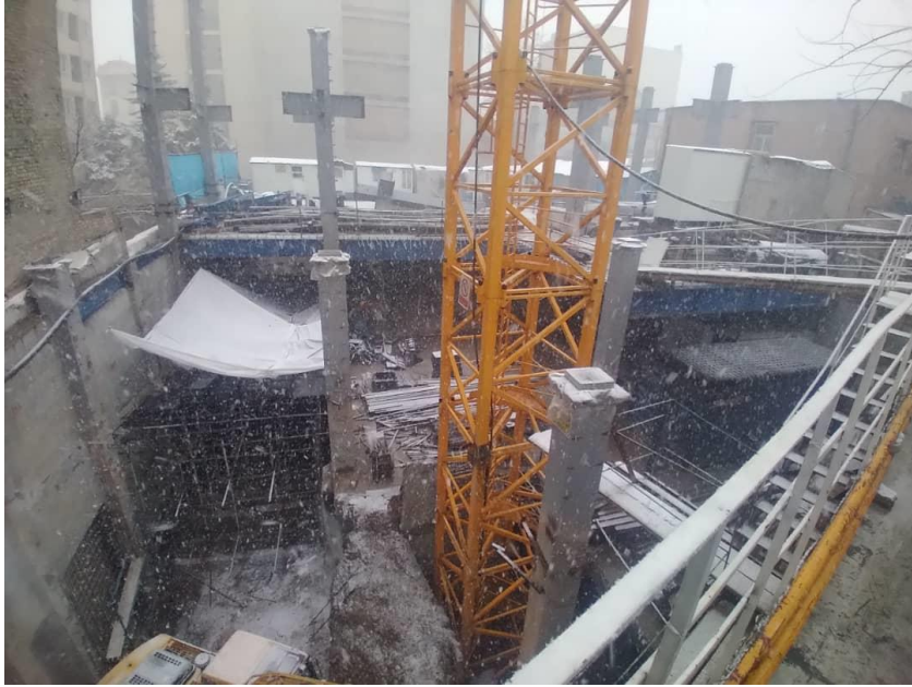
شکل ۱۸-۱ پروژه شهید کلاهدوز - الگوی بومی - اسکلت فلزی - سقف طبقات زیرزمین دال وافل، عمق گودبرداری ۲۲ متر
