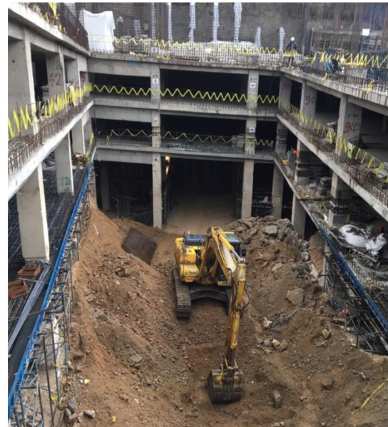
شکل ۱-۱۳ پروژه پارکینگ طبقاتی نیایش - الگوی بومی - اسکلت بتنی با ستون‌های پیش‌ساخته - عمق گودبرداری ۳۵ متر
