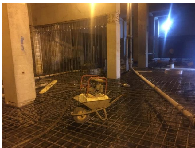
شکل ۳-۱۱۴ اجرای پی در ستون‌های پیش‌ساخته بتنی و اتصال میلگردهای پی به وصله‌های انتظار از پیش موجود در ستون‌ها
