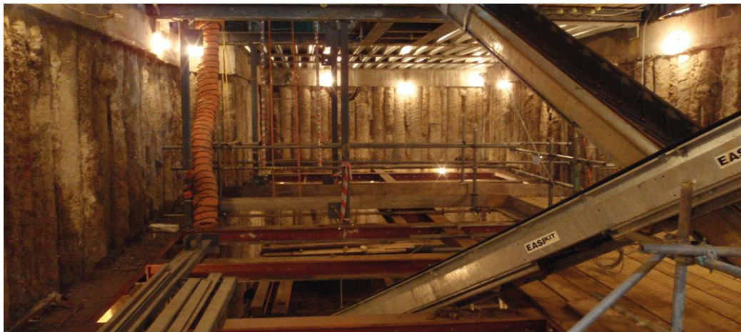
شکل ۳-۸۵ تخلیه خاک‌های کنده شده به بیرون از سایت از طریق بازشوهای خروجی سقف به وسیله نوارهای نقاله در اجرای سازه به روش بالا-پایین
